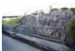
防護柵設置工事
