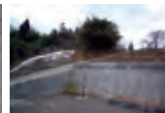
参道造成、擁壁新設工事
