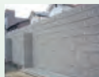
境界ブロック新設工事
