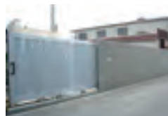
アルミ門扉新設工事
