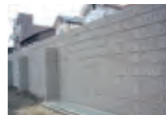
境界ブロック新設工事
