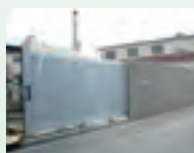
アルミ門扉新設工事
